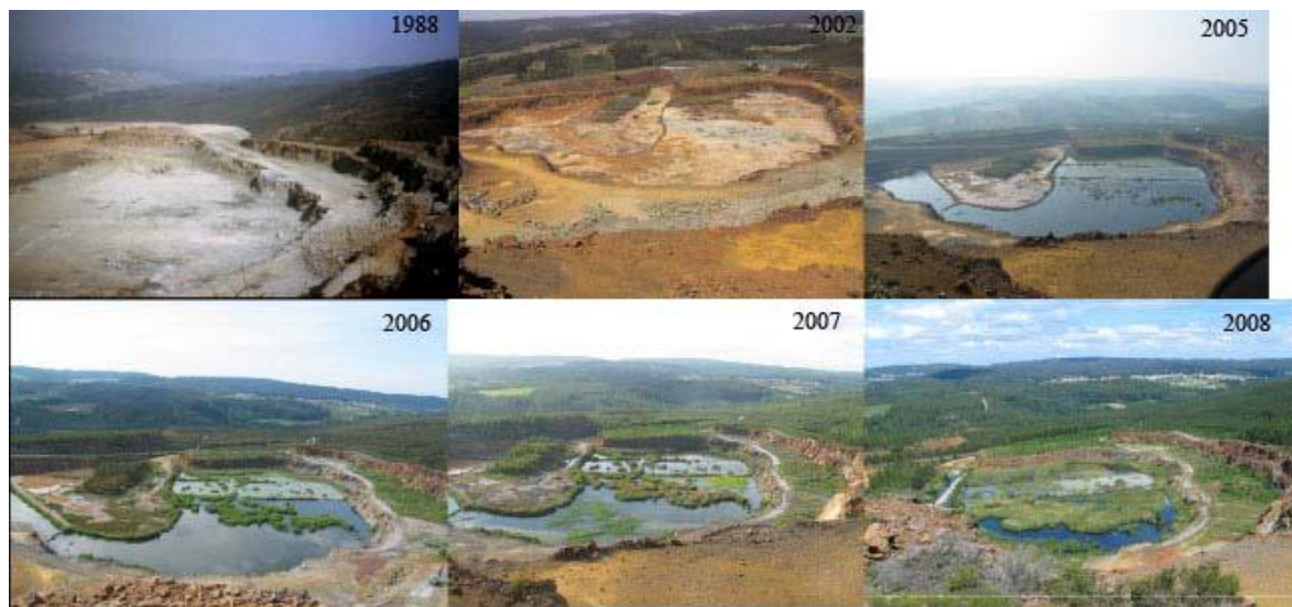
Figura 5. Evolución de la corta de Bama donde se ha instalado un sistema de depuración de aguas ácidas de mina (AMD) con Tecnosoles reactivos y un humedal de condiciones subóxicas.
