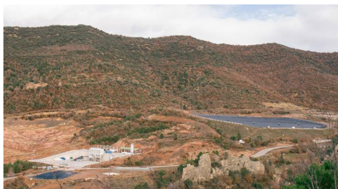
Figura 11. Celda de seguridad próxima al vertedero de Bailín – (Brunat, 2019)
