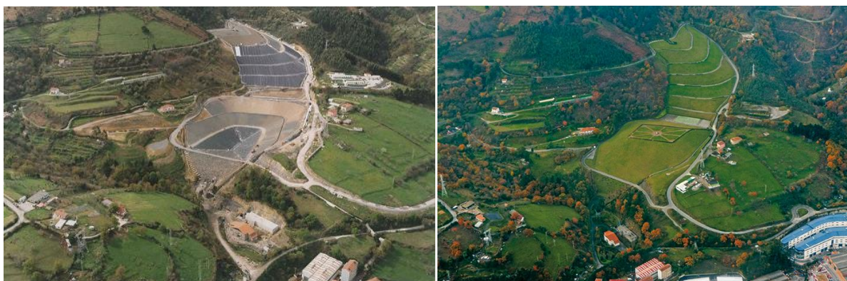
Figura 9. Celda de seguridad del emplazamiento de Argalarrio (antes y después) – (IHOBE, 2018)
